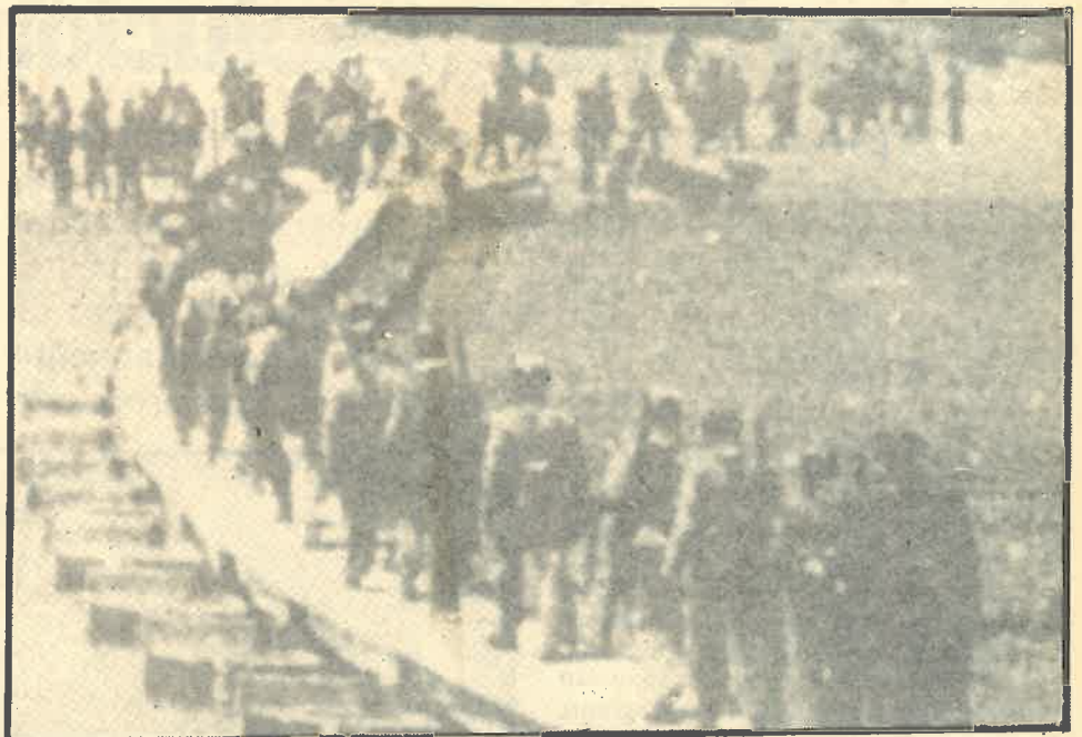
Aunque nos tiren el puente, y también la pasarela...
