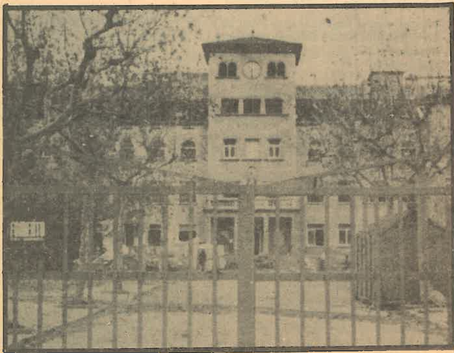
La Generalitat tiene paralizadas las obras del hospital de Sant Llorenç, sin que parezca tener interés en terminar las obras.
